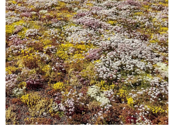
Sedum- och ängstak, dagvattenfördröjning
